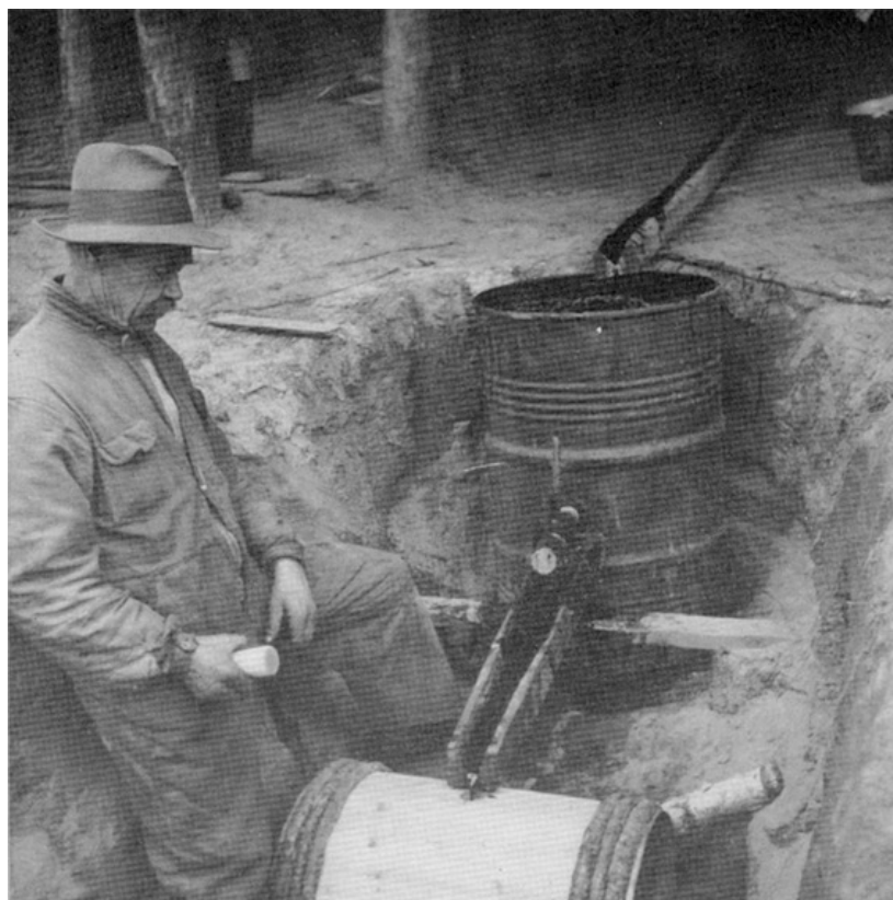
Tjäran avtappas genom en ränna från dalens centrum. Vid tjäruttaget tjänstgör ett bensinfat som magasin, varifrån tjäran tappas i tunnan. Åskilje, Degerfors kn. 1936 Foto 14. V Lundgren, STF:s bildarkiv
